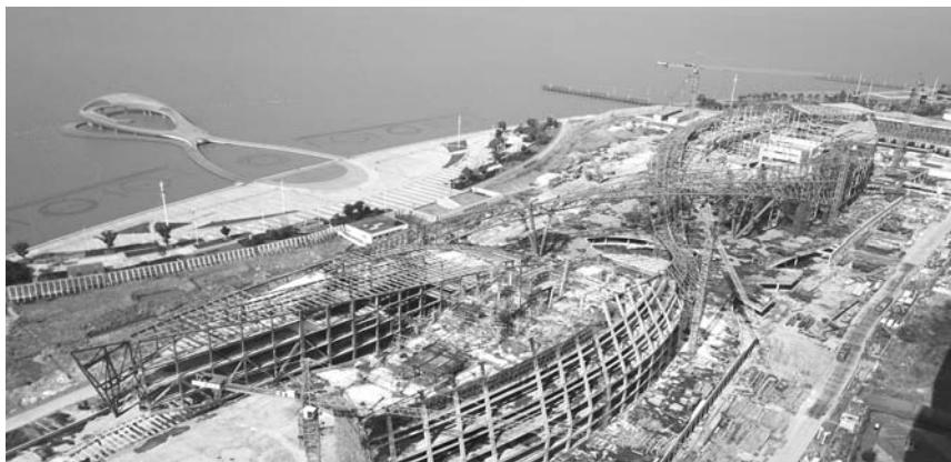
2月5日，中建三局承建的苏州湾文化中心全国最长、跨度最大的空间弯扭管桁架“钢飘带”顺利合龙。
