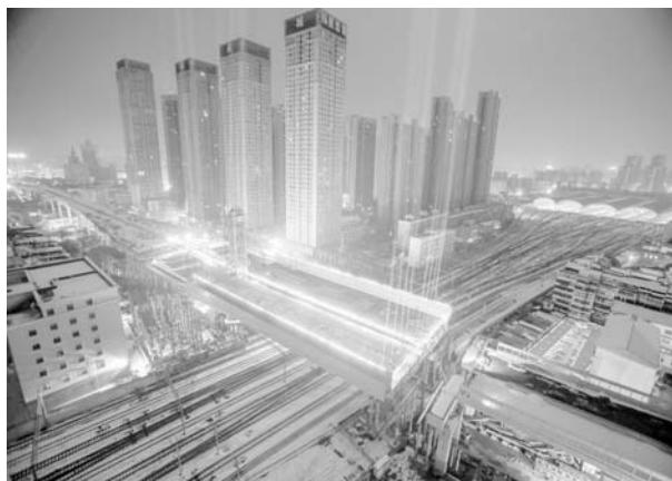
近日，由中建三局等投资建设的武汉汉江大道常青路转体桥，历时 87 分钟顺时针转动 81.003 度，与主线高架桥精准合龙，轴线偏差仅 0.5 毫米。这座我国首个极不平衡转体桥，创造了转体最不平衡、转体桥面最宽、跨越铁路股道最多三项世界转体桥新纪录。
