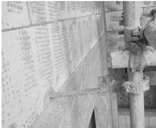
图4 外墙抗渗漏连墙件
