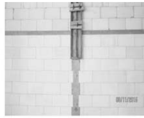
图 3-10 构造柱混凝土平整、密实、美观
