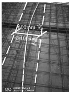
图 3-4 (管线密集处加放钢筋网片)
