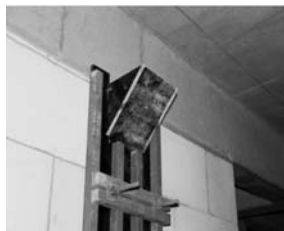
图 3-9 构造柱定型模安装
