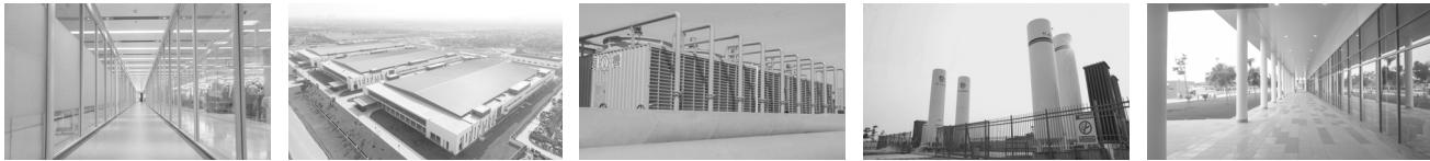
国一冶通过洁净板无缝安装、密封拼接、FFU 过滤单元，以及新风加压等措施来保证室内空气洁净度及温湿度要求。同时，项目运用“BIM+”智慧建造、二维码等多新技术，在钢筋混凝土、钢结构、绿色环保等建筑技术领域取得突破，共获得专利 12 项。该项目主体结构采用装配式钢结构制作安装，总量达 16800 吨。中国一冶通过 BIM 技术深化设计，726 根钢柱，2109 根钢梁制作、运输、安装全过程运用二维码技术进行全数编号。这相当于给每一个构件上了“身份证”，手机扫一下，材料型号、质量自检情况、现场安装位置等信息一清二楚，做到每一块钢板都可全程追溯，极大提升了安装精度及效率。据统计，该项目总计 223110 根高强螺栓，一次性穿孔率达到 99.1%。
