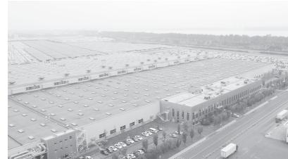
50天完成钢梁桁架吊装，60天完成各种管道、管线布置，35天铺完车间屋面8万平面积防水卷材……一连串数字组合在一起，便是上汽通用项目厂房不断上演的“建设时速”。通过土建与钢构、钢构与机电安装施工立体穿插的方式，分区、分仓、分层实现流水作业，中国一冶破除了施工面积大、作业点多面广的难题，仅仅用了360天便完成了上汽通用发动机项目三期8万8千平厂房的建设，刷新了上汽通用汽车配套发动机项目的落地新速度。
