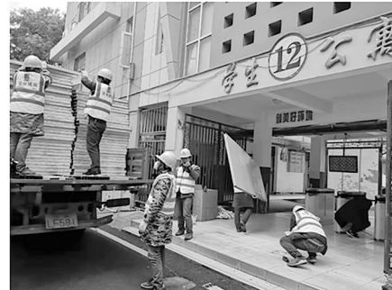
2月10日,公司再次接到武汉软件工程职业学院学生公寓改建方舱医院的紧急施工任务,克服工期紧、任务重,材料短缺、运输困难等难题,青年突击队昼夜连续施工,至2月13日晚上7点,按时顺利完成10#、12#学生公寓改建医护无菌通道和封闭消杀区全部施工任务,完成轻质彩钢板隔断、吊顶、照明、给排水、门窗等施工,建筑面积近19000平方米,新增600余张床位。
