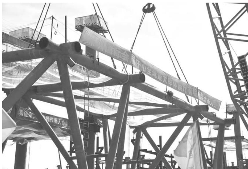
吊速度，提升速度要控制在0.8m/分钟，行走速度控制在0.5m/分钟，构件在高空转动幅度不能超过 $\pm 5^\circ$ 。最终吊装过程安全可控，高空转动幅度控制在 $\pm 3^\circ$ ，肉眼几乎看不到晃动，赢得现场一片掌声，在工友们的笑容中重桥桁架稳稳的落在了钢柱上。
