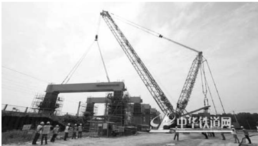
图5 门式墩成功安装现场图片
